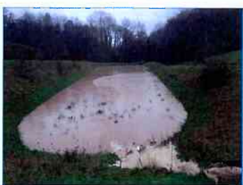
Les ouvrages de régulation
