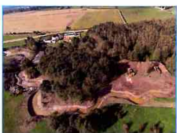
La restauration de la continuité écologique
